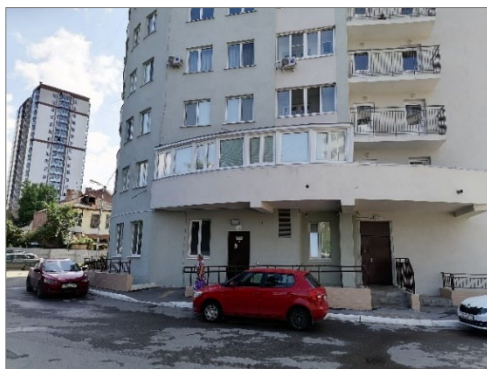
Рис. 2. Общий вид помещения на козырьке многоквартирного дома в г. Самаре (фото автора)
