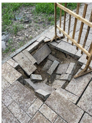
Рис. 4. Разрушение тротуарного (А) и дорожного (Б) покрытия в результате суффозии*
