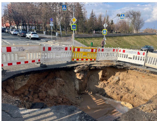
Рис. 4. Разрушение тротуарного (А) и дорожного (Б) покрытия в результате суффозии*
