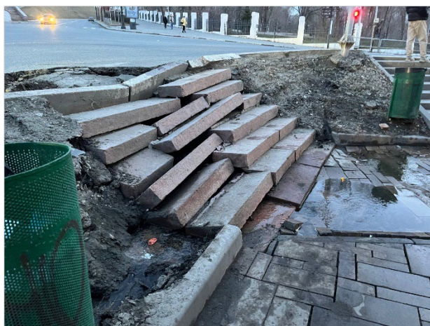
Рис. 2. Разрушение лестницы под действием потоков стекающей по склону воды*
