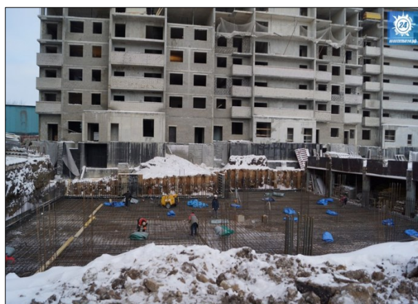
Рис. Устройство свайного фундамента при строительстве жилого комплекса "Желябово РФ"
